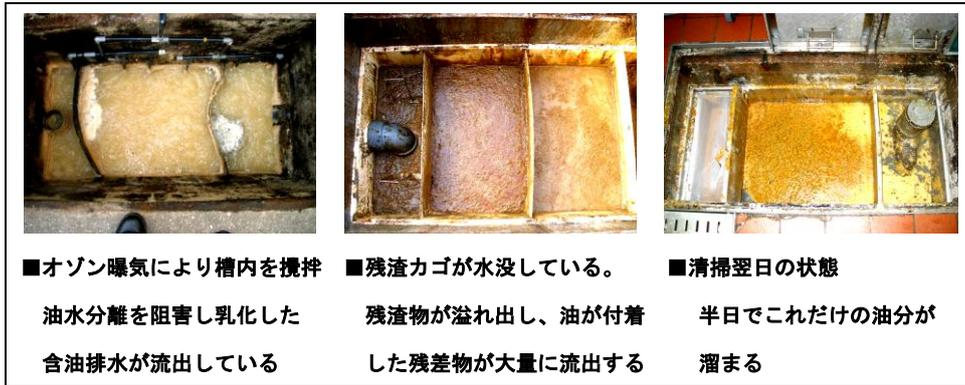
※資料 21 ■バイオ・酵素+ばっ気装置による処理の実情
